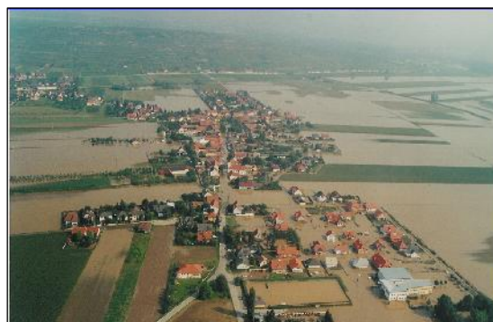
Скъсване на язовирна стена
