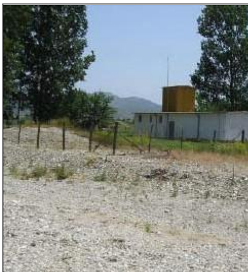
Помпена станция при с.Фотиново
